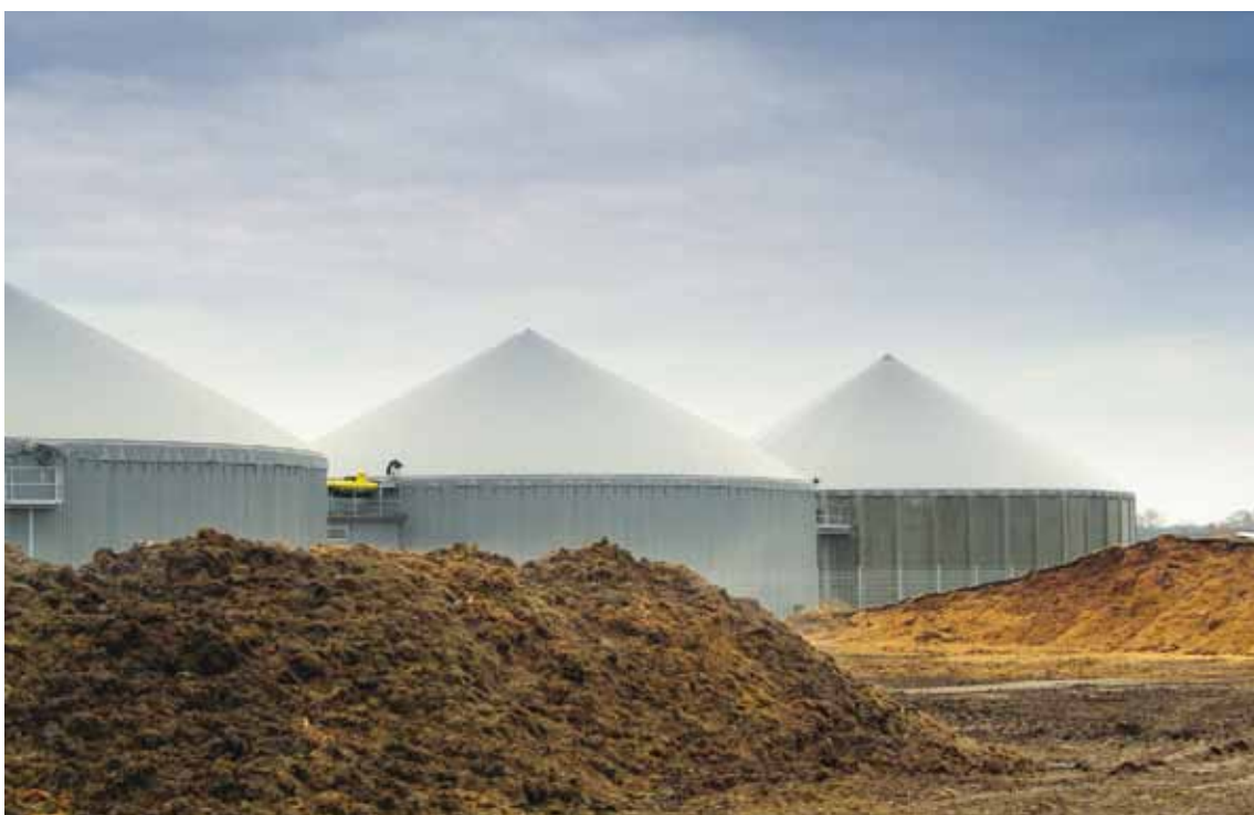
Planta de Biogás.
